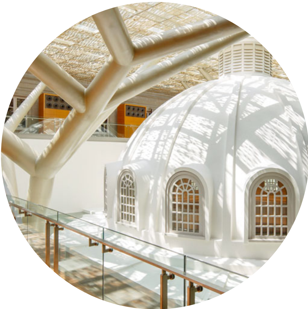
Nationalgalerie Singapur Eine Decke aus Glas und Metall verbindet zwei Kolonialgebäude zur neuen Nationalgalerie.
